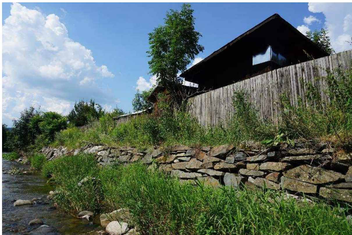
23. SO 05 – stávající opevnění na PB
