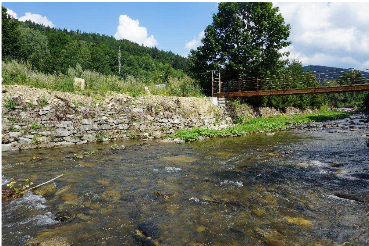
17. SO 04 – stávající opevnění na PB
