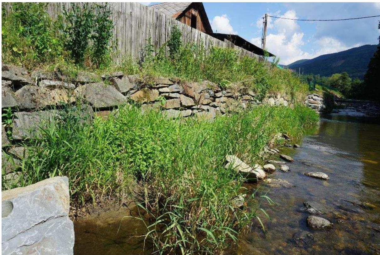
22. SO 05 – stávající opevnění na PB
